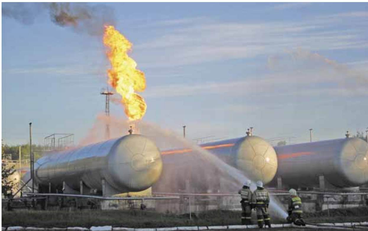
Рис. 33. Авария на базе хранения СУГ (ГНС г. Казань)
